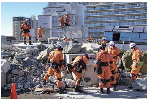
国際消防救助隊 (IRT) の訓練
